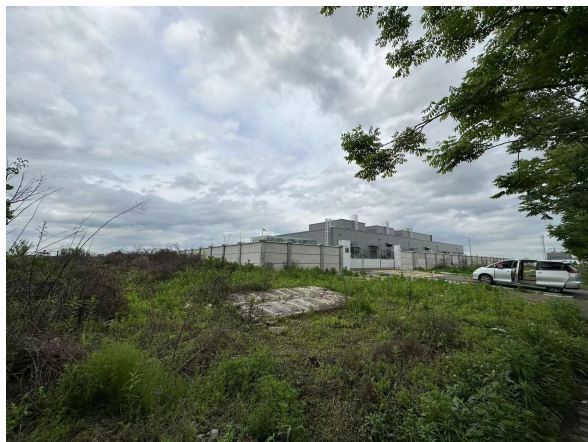
图 6-7 变电站远景及周边生态环境现状
