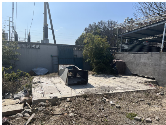
图 6-4 电缆线路周边环境现状
