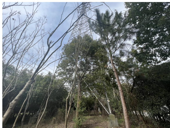
图 6-2 架空线路周边环境现状
