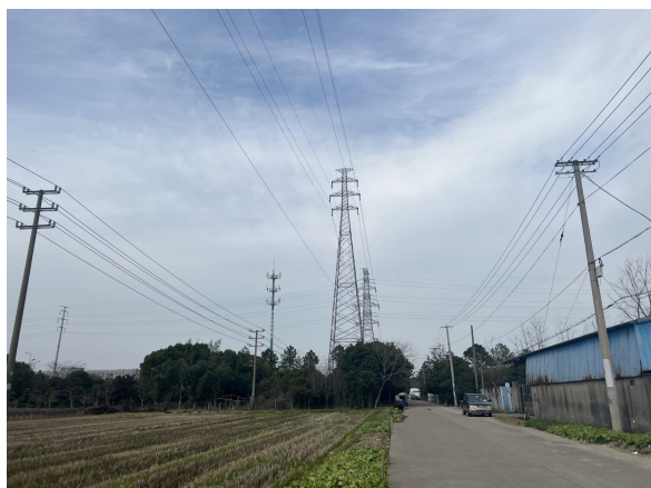
图 6-3 架空线路周边环境现状
