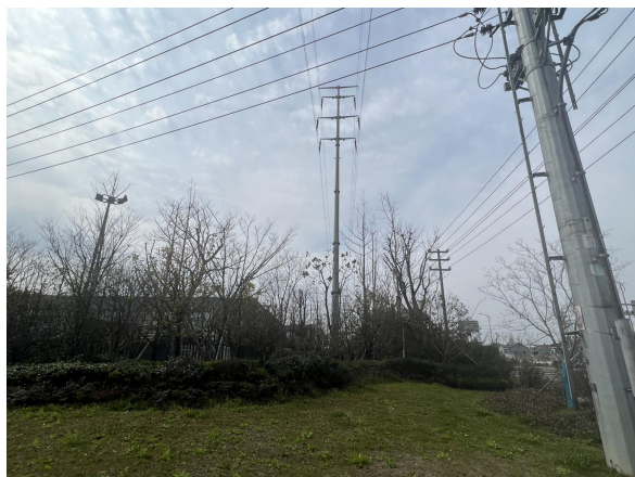
图 6-1 架空线路周边环境现状
