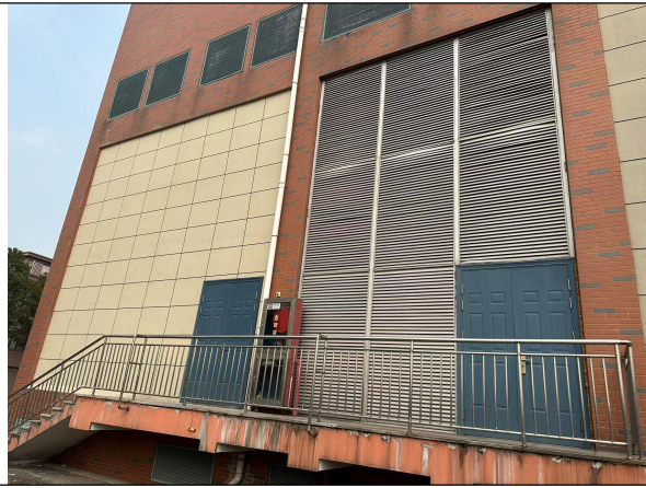
图 6-1 本期扩建 3#主变（户内布置）
