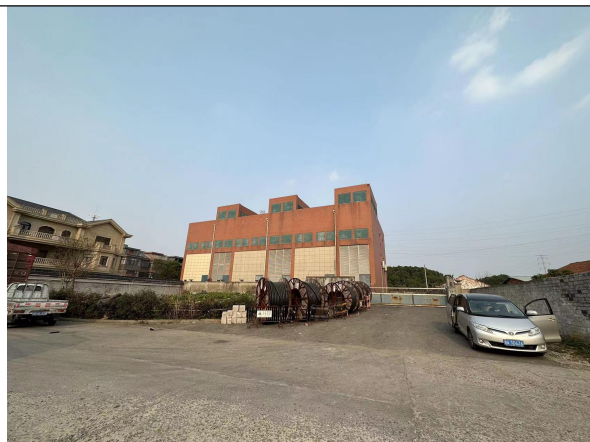
图 6-7 变电站远景及周边生态环境现状
