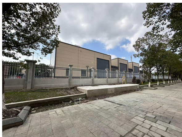
图 6-10 变电站远景及周边生态环境现状
