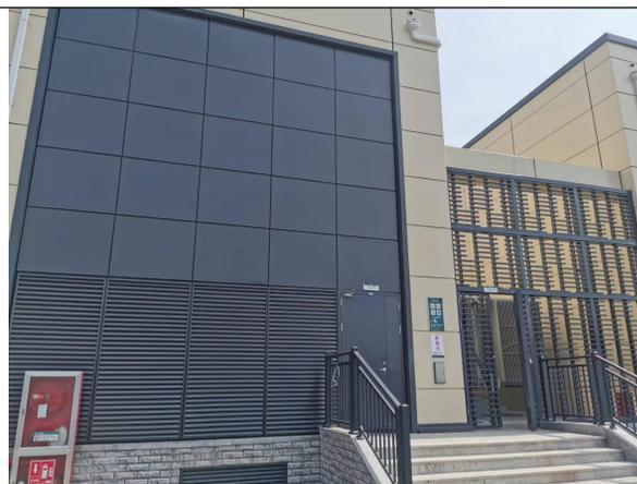
图 6-2 主变户内布置，散热器户外布置
