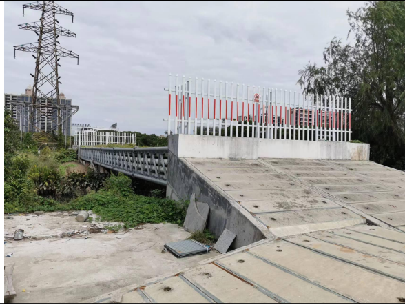
图 6-3 本期改造电缆线路周边环境现状
