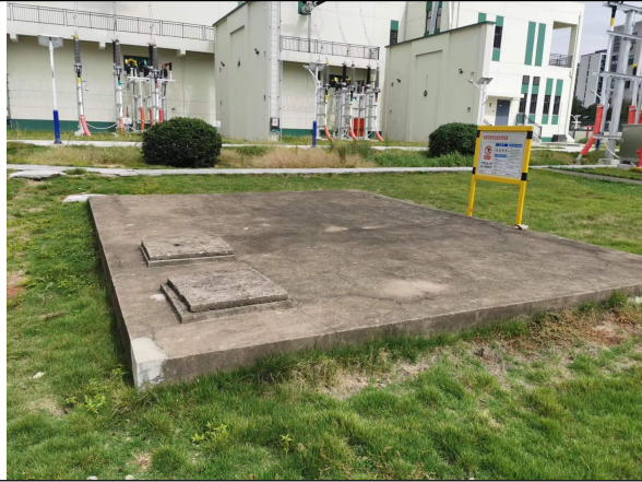
图 6-5 原有事故油池
