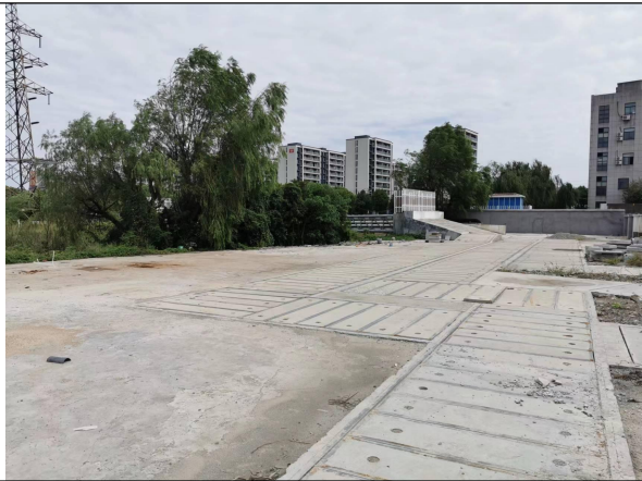
图 6-2 本期改造电缆线路周边环境现状
