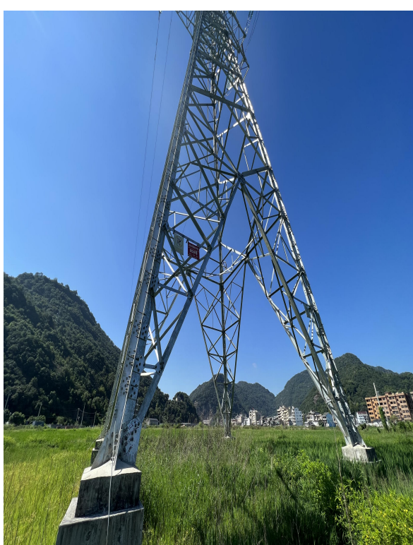
图 6-4 塔基周边植被恢复现状
