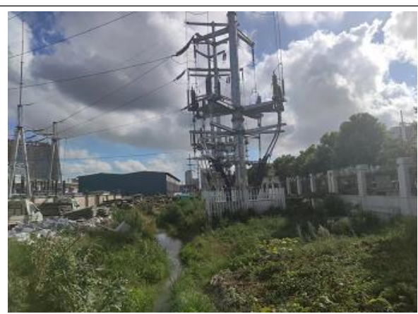
图 6-4 塔基周边环境现状
