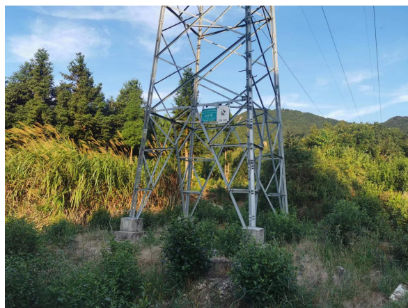
图 6-4 塔基周边植被恢复现状
