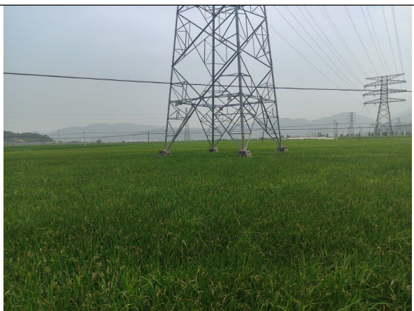
图 6-2 塔基周边环境现状
