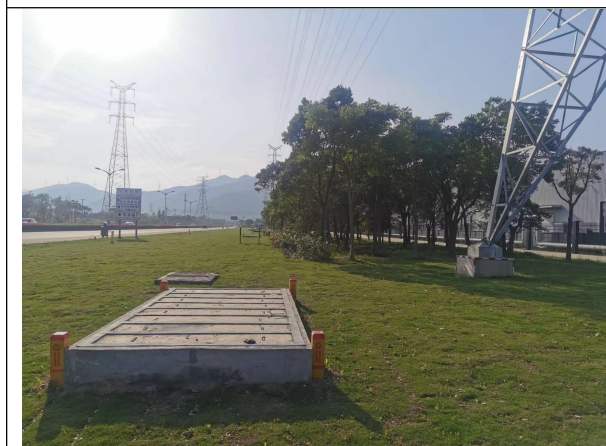
图 6-3 架空线路、电缆线路周边环境现状
