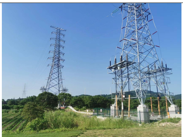
图 6-2 架空线路周边环境现状
