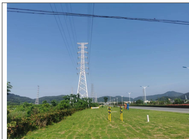
图 6-1 架空线路、电缆线路周边环境现状
