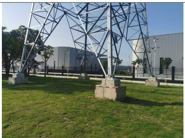
图 6-4 塔基下方植被恢复情况
