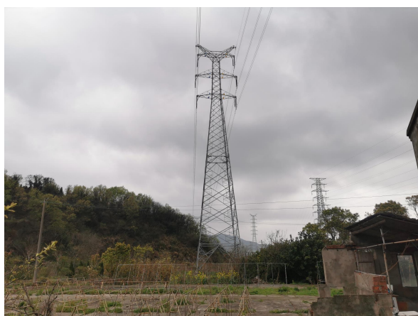
图 6-9 架空线路周边环境现状
