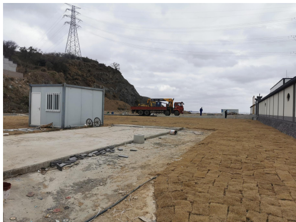
图 6-8 变电站周边环境现状
