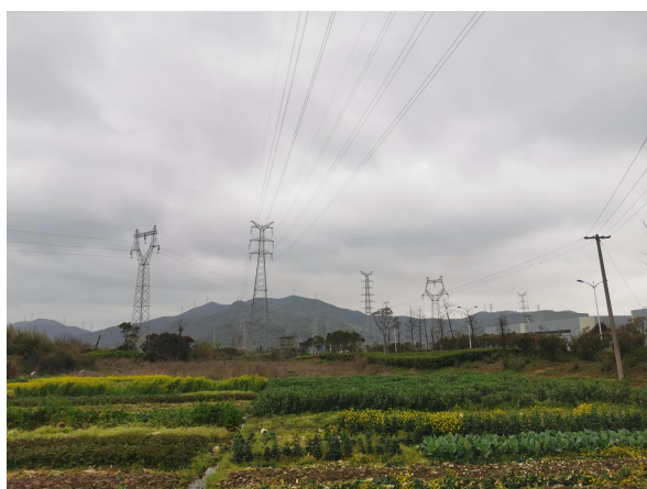
图 6-10 架空线路周边环境现状
