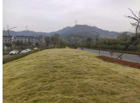
图 3-2 电缆线路沿线现状
