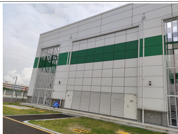
图 6-3 3#主变（终期未建）
