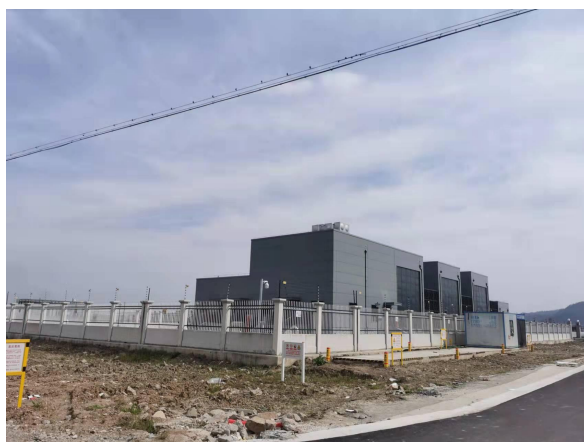
图 6-2 变电站远景及周边环境现状
