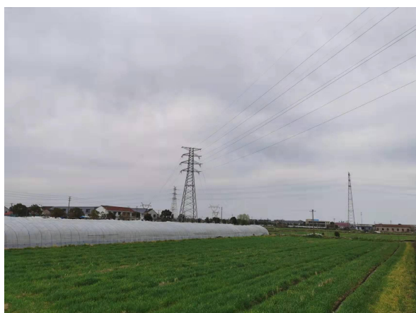
图 6-9 架空线路周边环境现状
