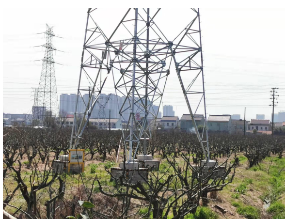
图 6-11 塔基下方植被恢复现状
