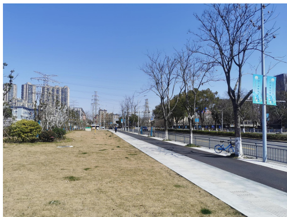
图 6-8 变电站周边生态环境恢复现状
