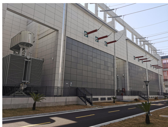
图 6-5 主变户内布置（散热器户外布置）
