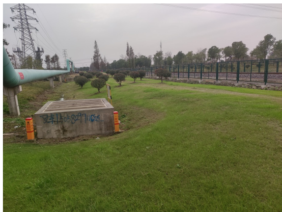
图 6-3 电缆线路周边环境状况
