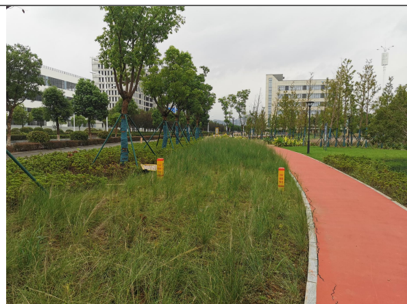
图 6-2 电缆线路周边环境现状
