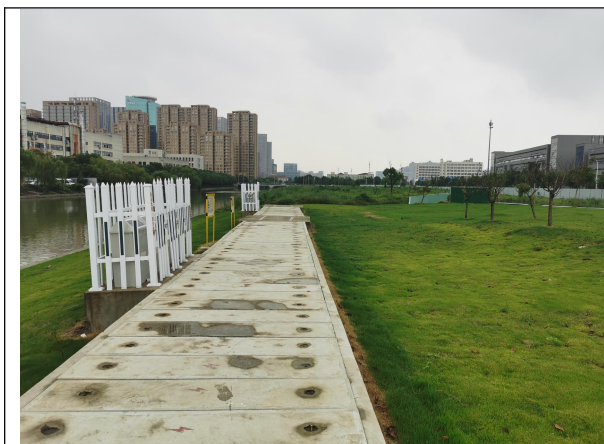
图 6-1 电缆线路周边环境现状
