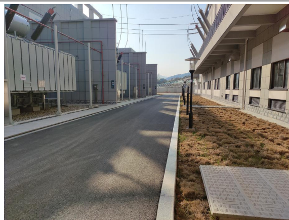
图 6-8 变电站内空地绿化
