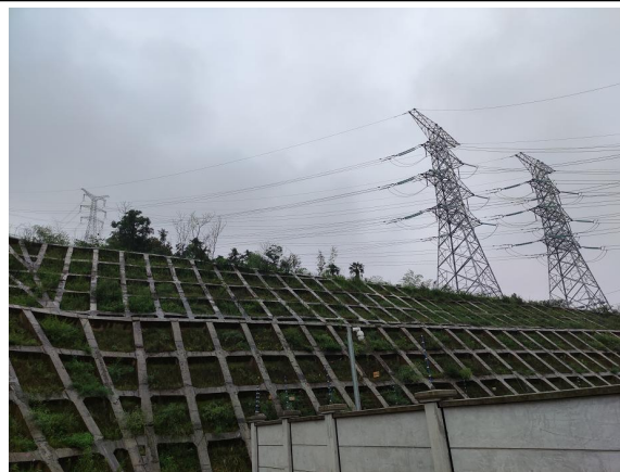
图 6-10 架空线路周边环境状况
