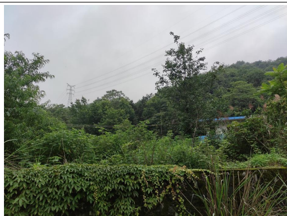
图 6-11 架空线路周边环境状况
