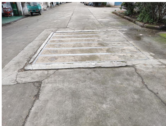
图 6-3 电缆线路周边环境状况
