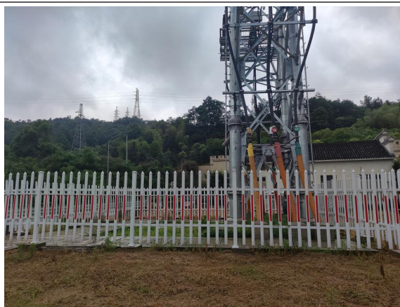
图 6-6 塔基周边环境现状
