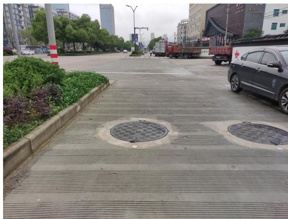
图 6-4 电缆线路周边环境状况
