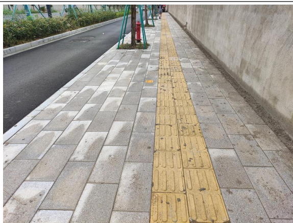
图 6-5 电缆线路周边环境现状
