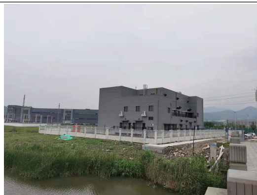
图 6-2 变电站远景及周边环境现状
