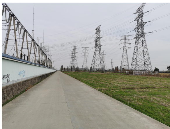
图 6-6 变电站周边环境现状
