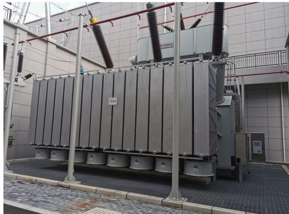
图 6-1 2#主变及下方油坑
