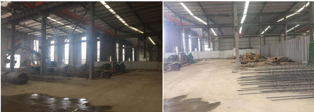
车间内加速机房东侧实景图
