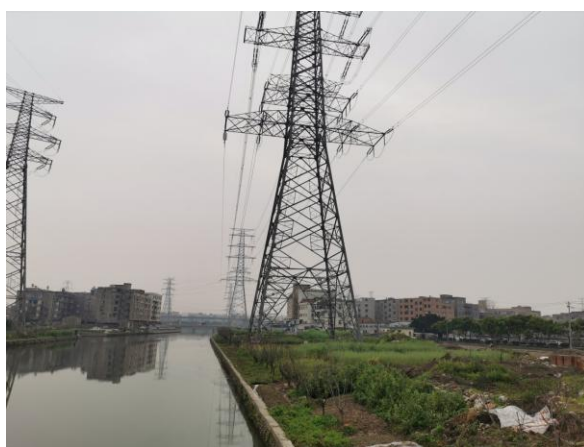
图 6-12 线路周边环境现状（同塔 4 回混压段）
