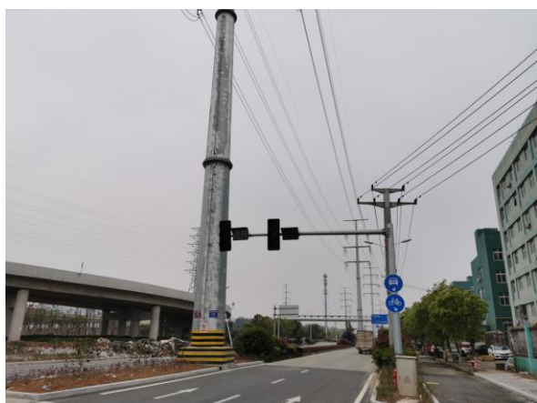
图 6-9 线路周边环境现状（杆塔段）
