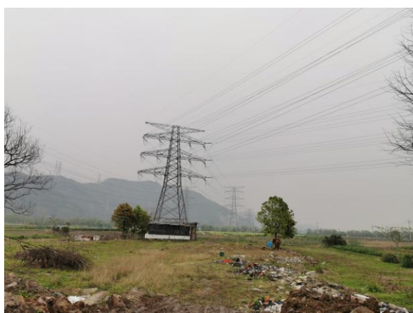
图 6-11 线路周边环境现状（同塔 4 回段）
