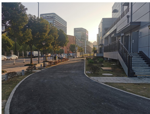
图 6-6 变电站内道路及绿化
