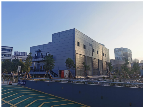
图 6-1 变电站远景及周边环境现状
