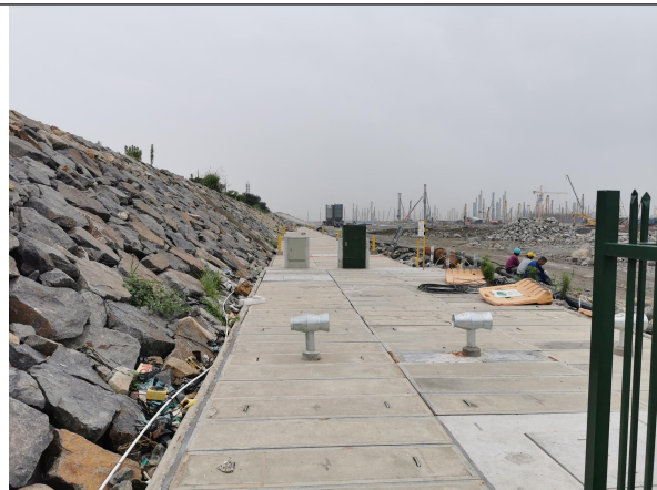
图 6-3 电缆线路走廊环境现状
