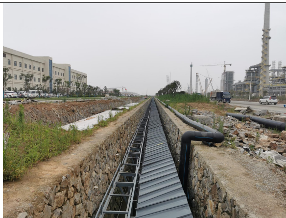
图 6-2 电缆线路走廊环境现状
