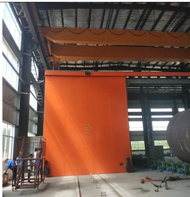
图（2）卷制焊管车间探伤室
