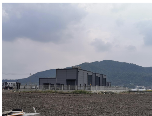
图 6-10 变电站整体环境现状
