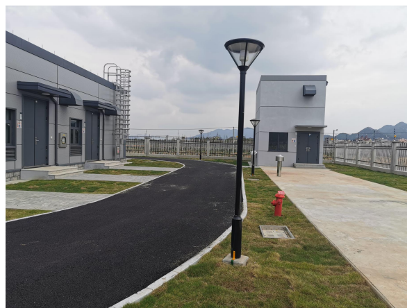
图 6-8 变电站内道路及绿化
