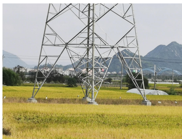
图 6-12 塔基下方植被恢复
