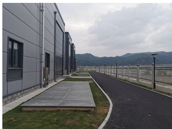
图 6-9 变电站内道路及绿化
