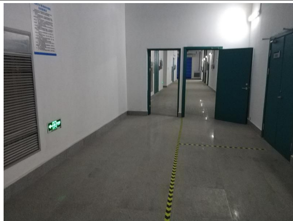
图 6-8 变电站内道路
