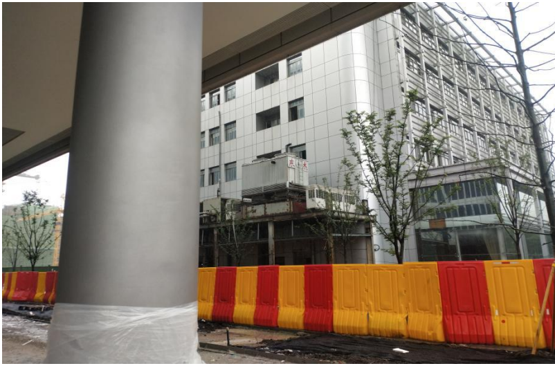
东侧-钱江制冷大楼
