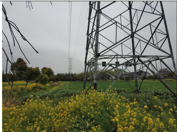
图 6-1 架空线路周边环境状况
