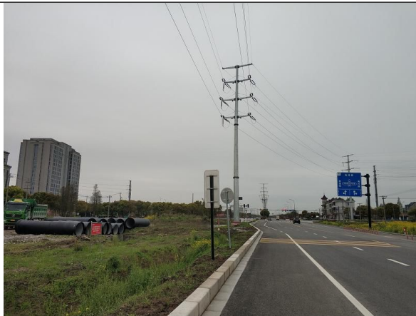
图 6-2 架空线路周边环境状况
