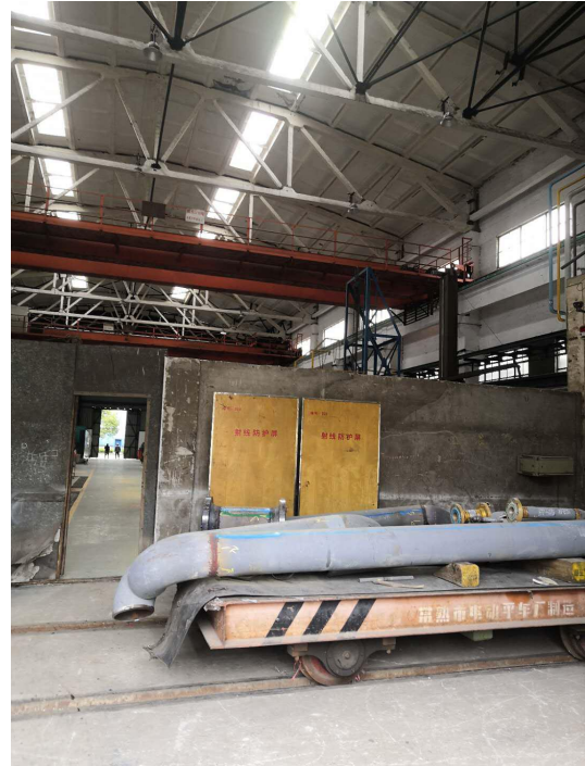
探伤室南侧车间
