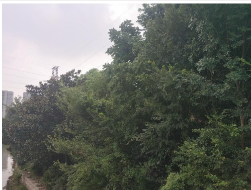
图 6-8 变电站周边环境状况
