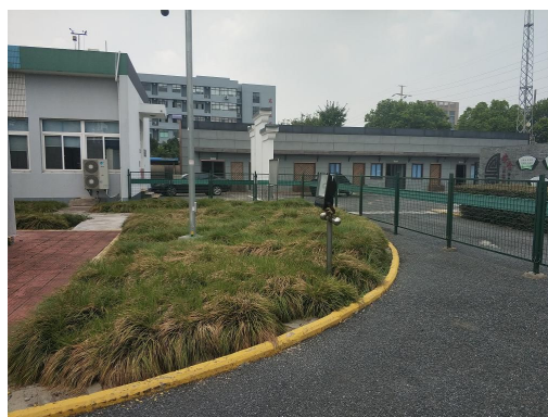
图 6-6 变电站内绿化
