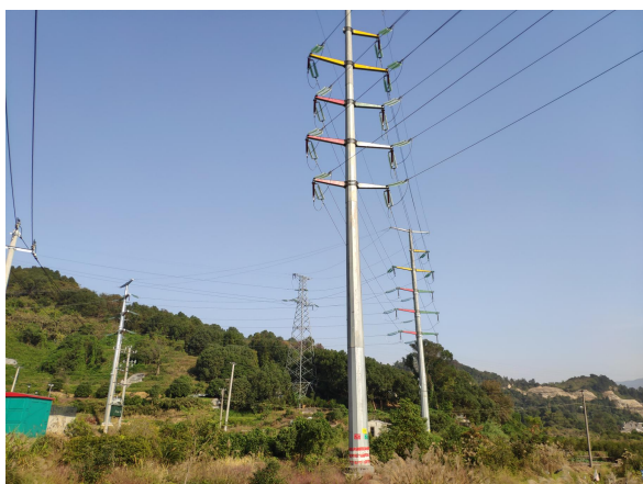
图 6-10 线路周边环境现状（架空线 3 回段）
