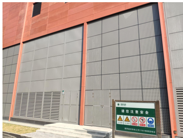
图 6-2 2#主变（油冷户内布置）
