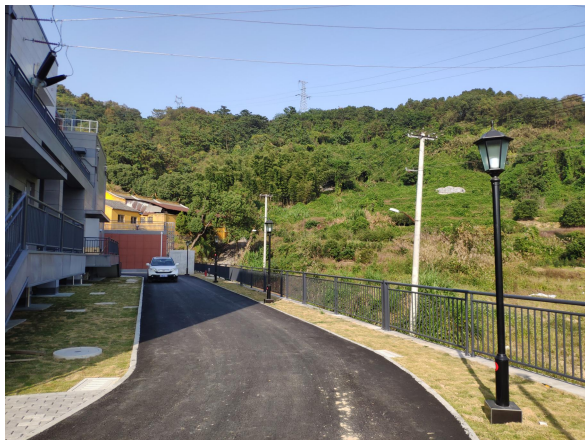
图 6-8 变电站内道路及绿化
