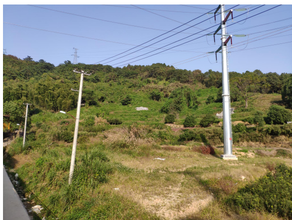
图 6-9 变电站周边环境现状
