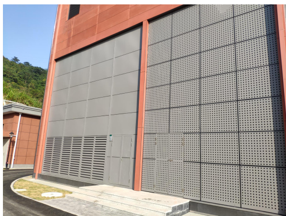
图 6-3 3#主变预留位置（油冷户内布置）
