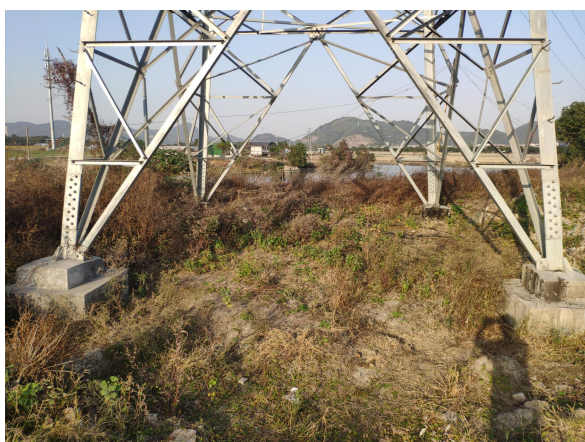
图 6-12 塔基植被恢复现状
