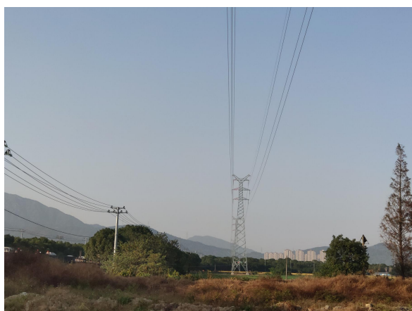
图 6-11 线路周边环境现状（架空线 2 回段）
