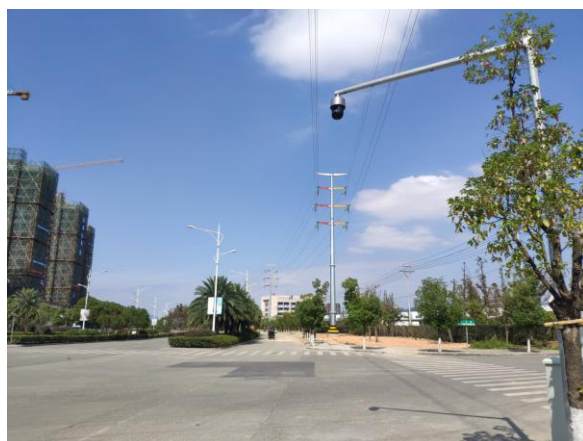
图 6-10 线路周边环境现状（架空线）
