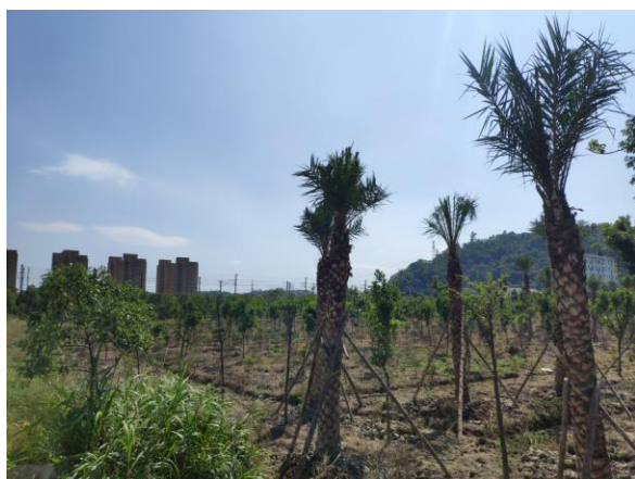
图 6-9 变电站周边环境现状
