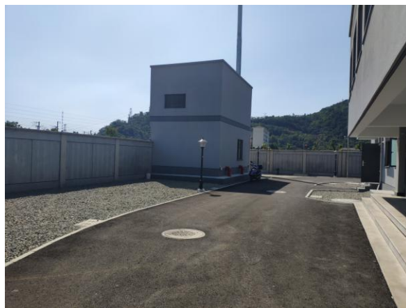
图 6-8 变电站内道路及碎石硬化
