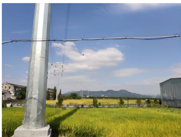
图 6-11 线路周边环境现状（架空线）
