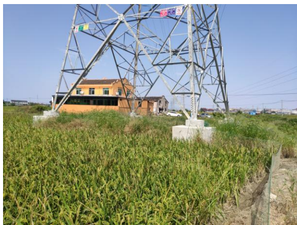
图 6-11 塔基植被恢复
