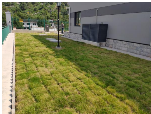
图 6-8 变电站内绿化
