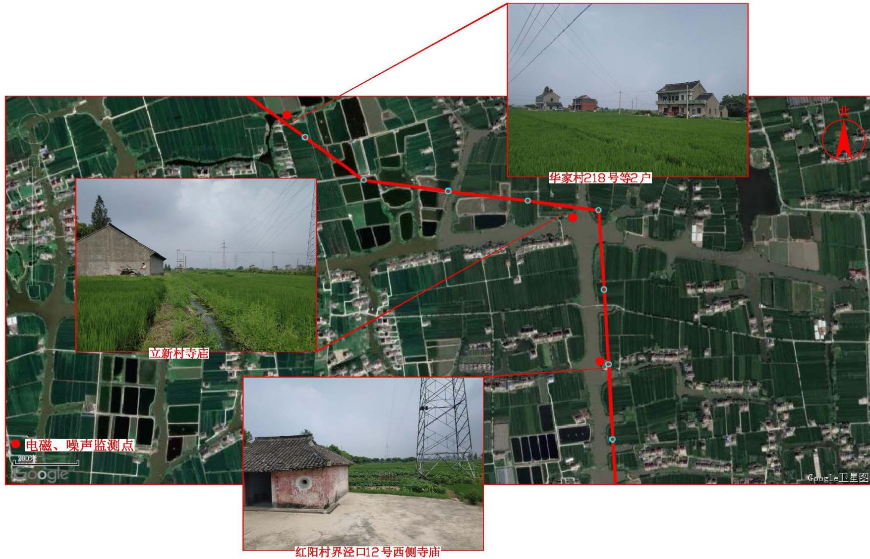
图 7-1 监测点位图 (14) (110kV 建虹 13183 线)
