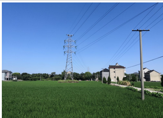
图 6-1 新黄线塔基周边环境状况
