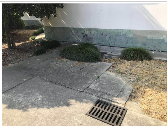
图 6-9 钱桥变化粪池
