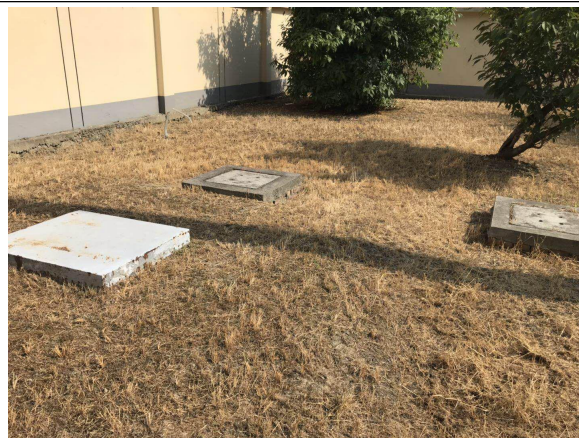
图 6-8 钱桥变事故油池
