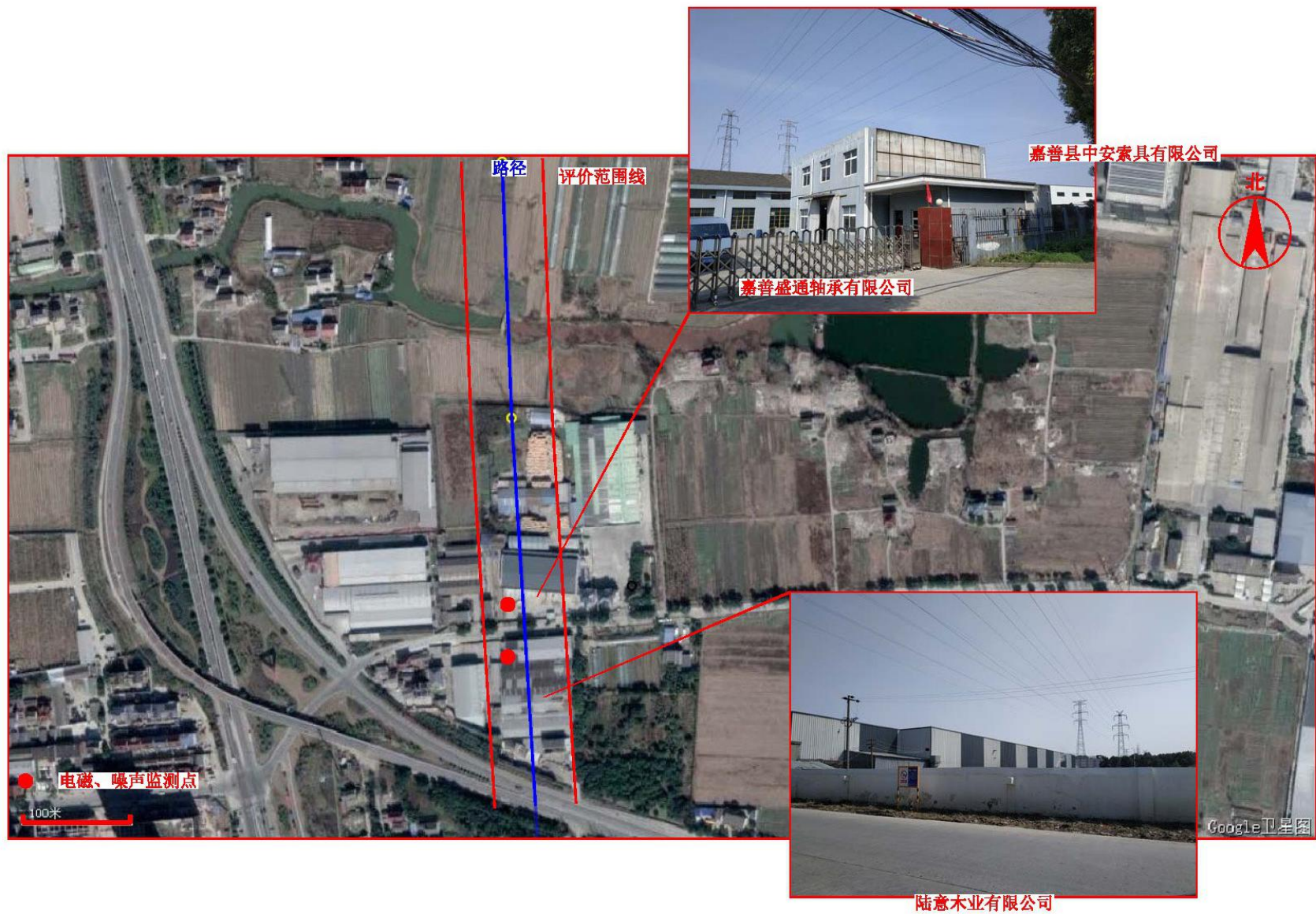
图 7-1 监测点位图 (8) (220kV 嘉铁 2P57 线、善铁 2P58 线)
