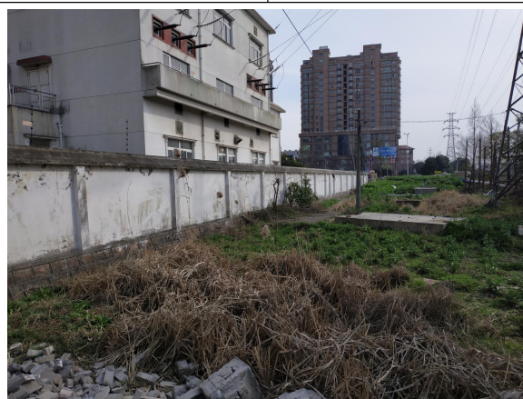
图 6-11 钱桥变周边环境现状
