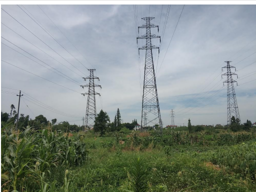
图 6-21 善魏线塔基周边环境状况
