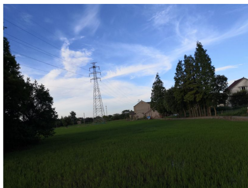
图 6-26 善溪线杨庙支线塔基周边环境状况
