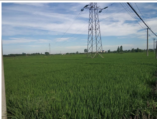
图 6-23 善溪线塔基周边环境状况
