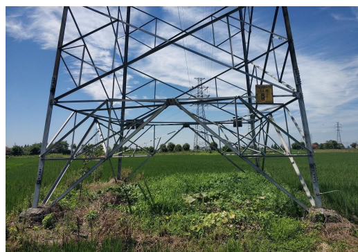
图 6-14 舜甸线塔基周边环境现状
