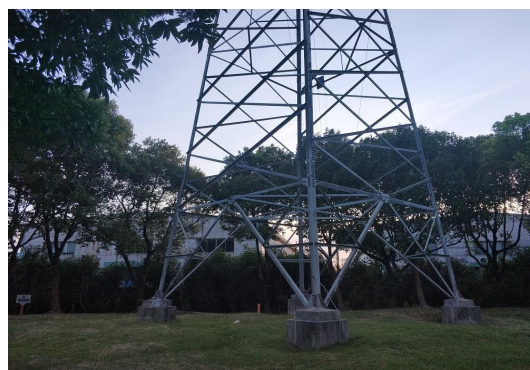
图 6-22 善魏线塔基周边环境状况
