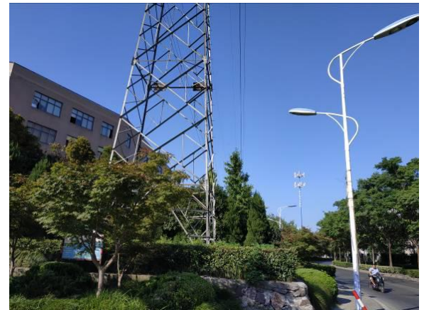
图 6-12 110kV 民江 1282 线走廊环境现状
