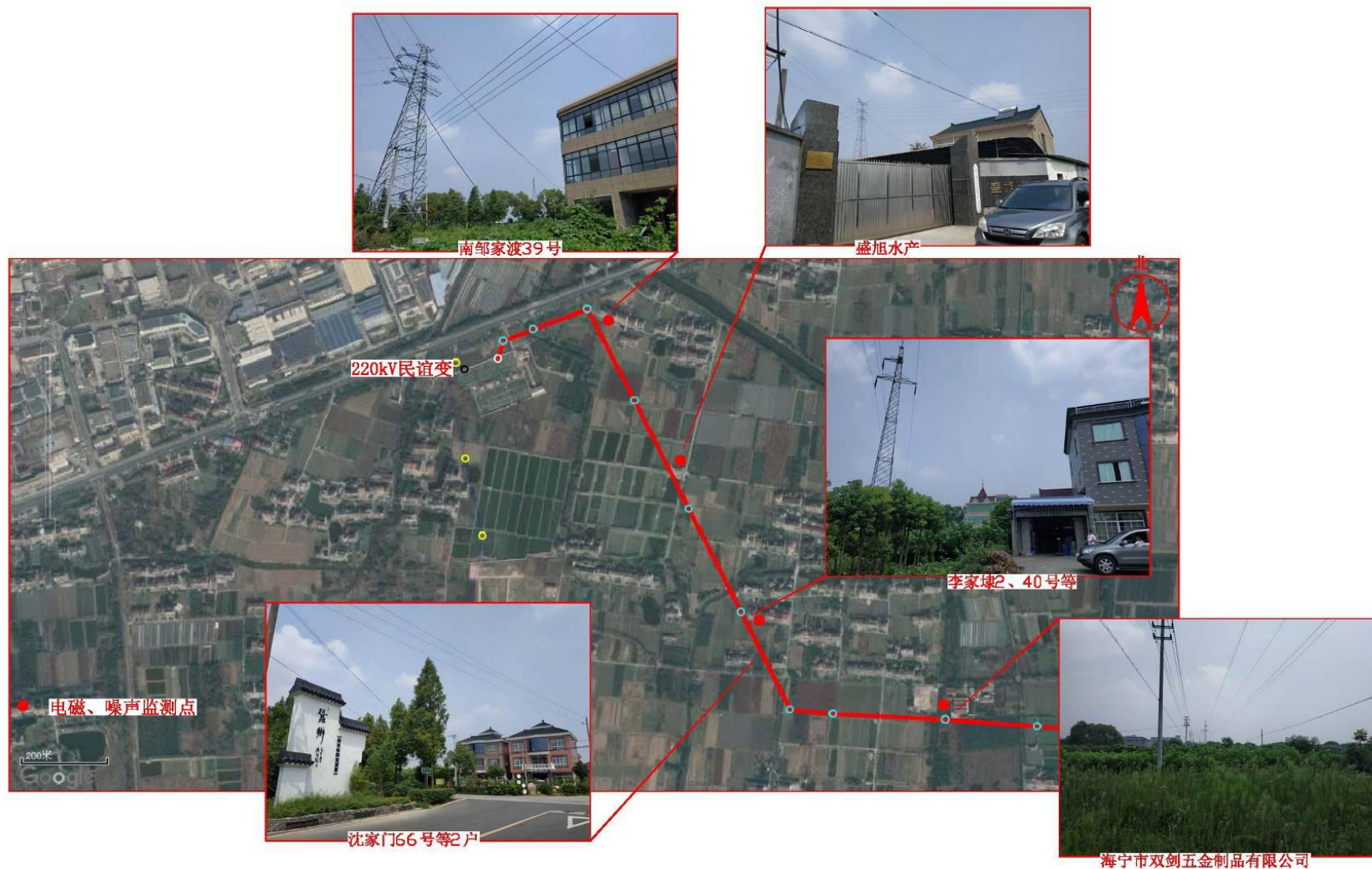
图 7-1 监测点位图 (10) (110kV 民盐 1292 线)
