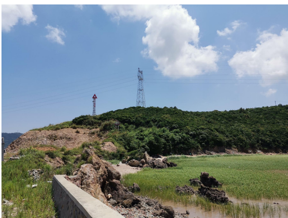
图 6-5 架空线路走廊环境现状
