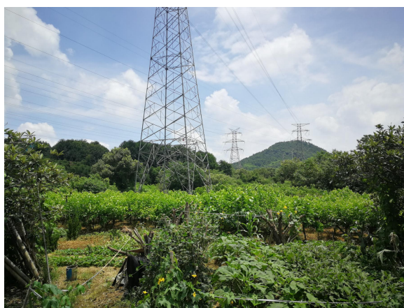
图 6-6 岱山变架空线路走廊环境现状
