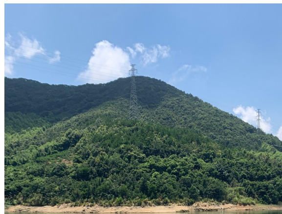
图 6-4 架空线路走廊环境现状
