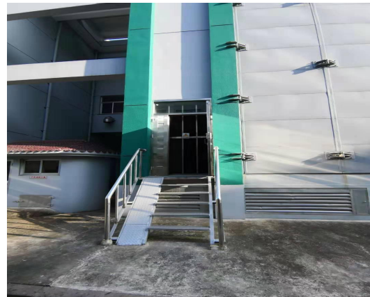
110kV 西范变电站现有主变
