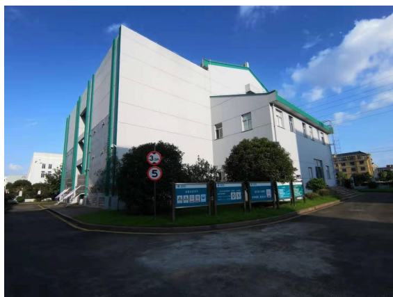
110kV 西范变电站主控楼
