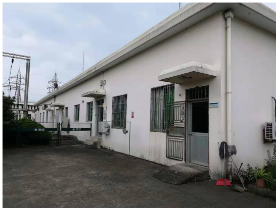
110kV 永宁变电站主控楼
