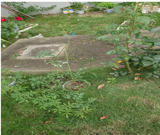
110kV 黄岩变电站污水处理设施
