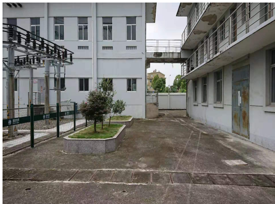
110kV 黄岩变电站主控楼
