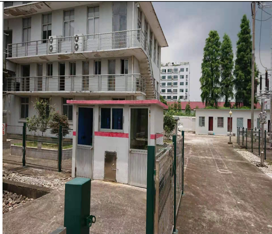
110kV 黄岩变电站主变消防室
