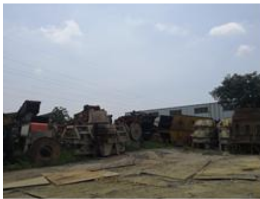
重金属拆解厂房
