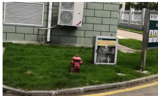
110kV 富仕变站内绿化及地面硬化
