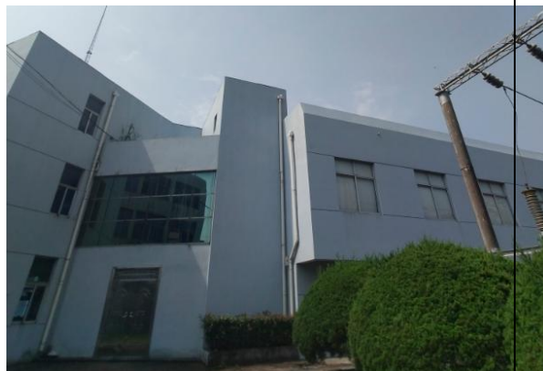
110kV 高升变电站主控楼
