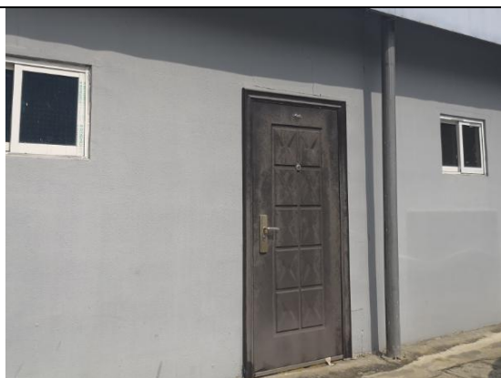
110kV 富仕变电站污水处理设施
