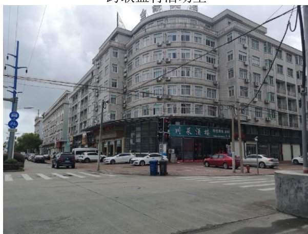
线西 27 米, 工业路 306-300
