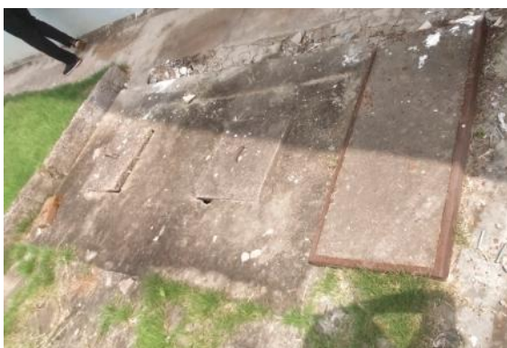
110kV 高升变电站污水处理设施
