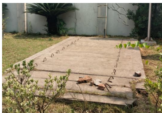
110kV 横街变电站事故油池
