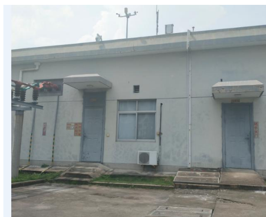
110kV 横街变电站主控楼
