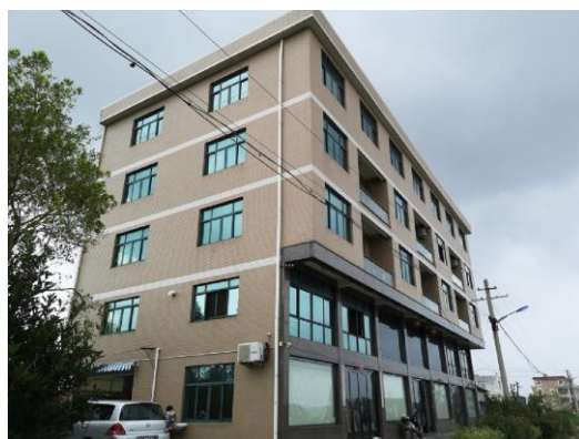
线东 8 米，上沈村居民楼
