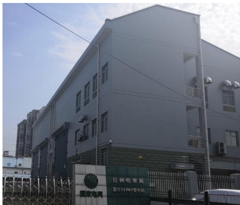
110kV 富仕变电站现有主变 2 台 (户内布置)
