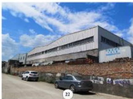
22 盛新锋机械有限公司厂房
