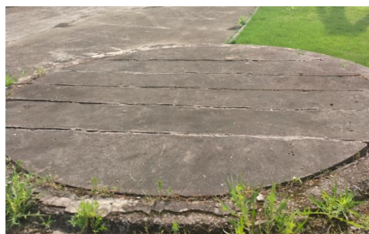
110kV 高升变电站事故油池
