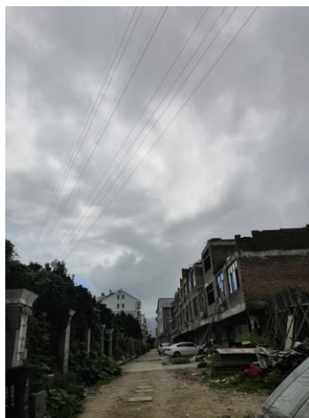
双狮村在建居民房国平 1836 线南侧约 10m
