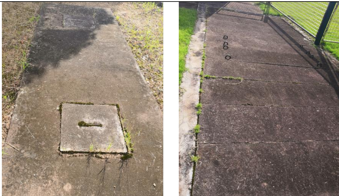
110kV 平镇变电站污水处理设施
