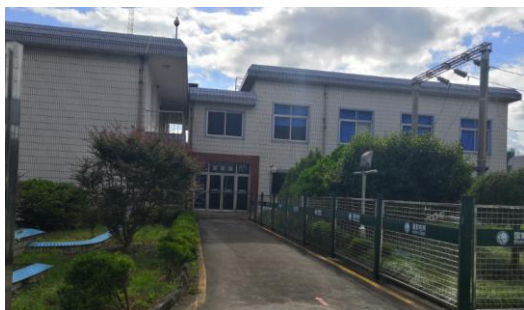
110kV 平镇变电站主控楼
