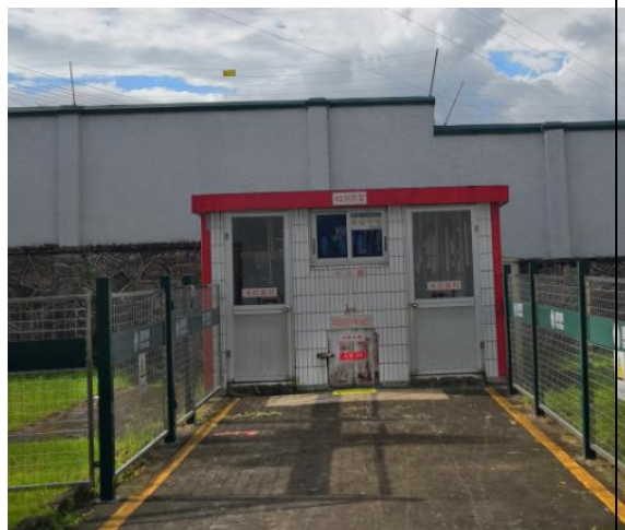
110kV 平镇变电站主变消防室
