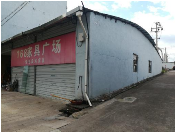
家具广场 变电站南侧 25m
