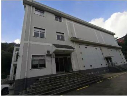
110kV 椒云变电站主控楼
