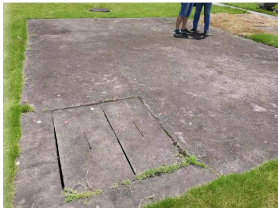
220kV 海门变电站事故油池
