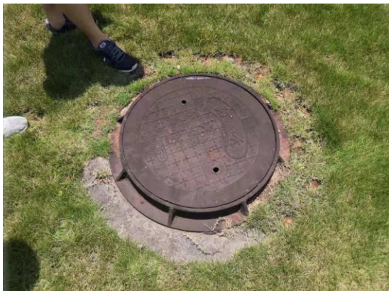
220kV 海门变电站污水处理设施
