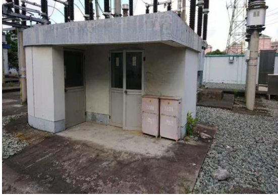
110kV 群辉变电站主变消防室
