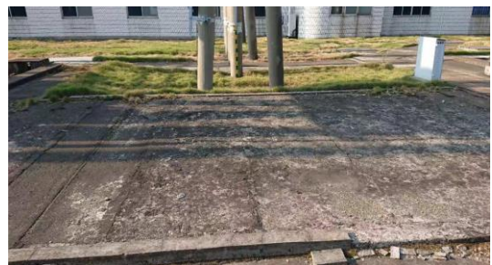
110kV 兆桥变电站事故油池
