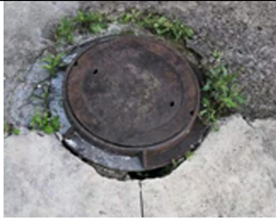
110kV 沙北变电站污水处理设施
