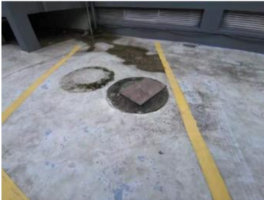
110kV 椒云变电站污水处理设施
