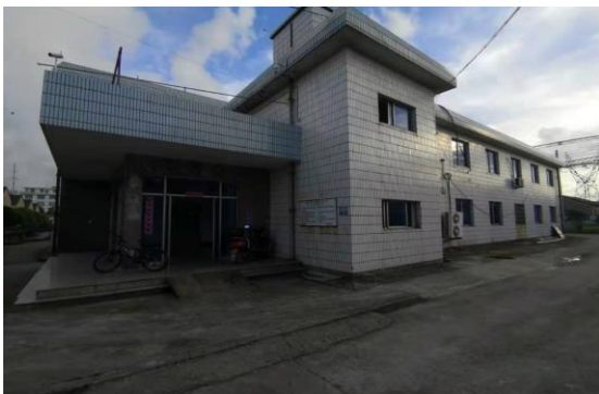
110kV 沙北变电站主控楼
