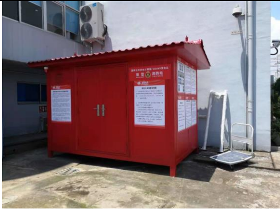
220kV 海门变电站主变消防室
