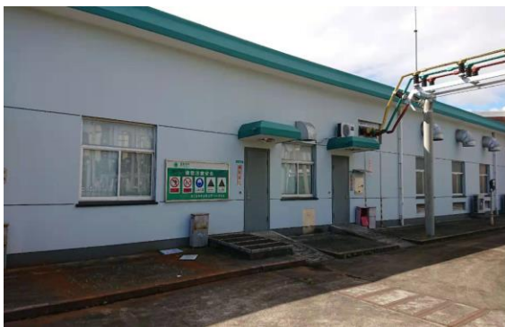
110kV 兆桥变电站主控楼
