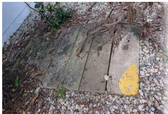
110kV 群辉变电站污水处理设施
