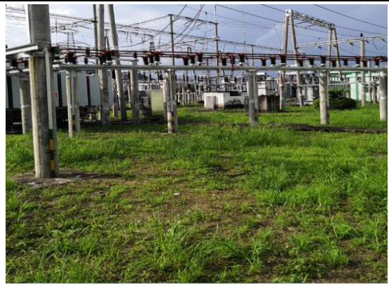
220kV 海门变电站站内绿化
