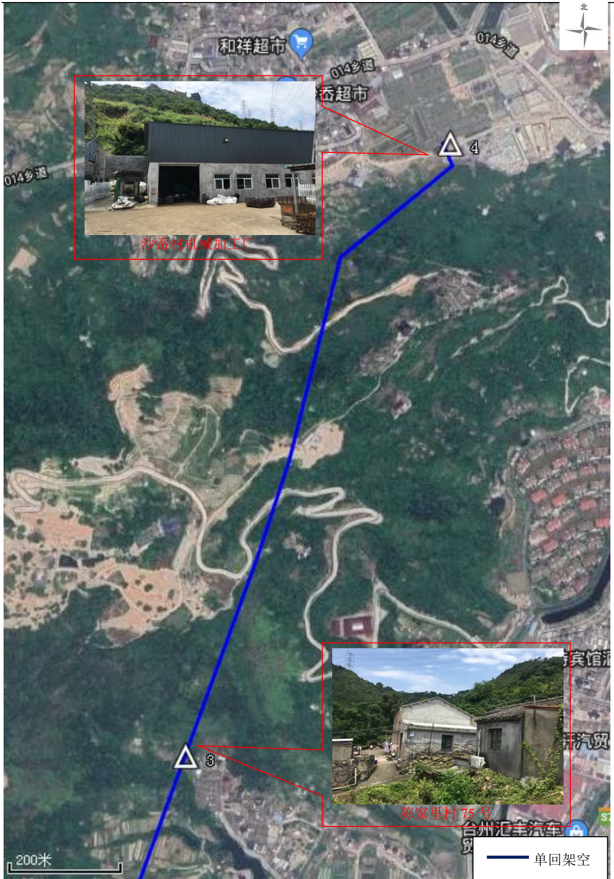
附图 3-11 110 kV 玉环输变电工程沙玉 1969 线 \Delta 3- \Delta 4 监测点位示意图
