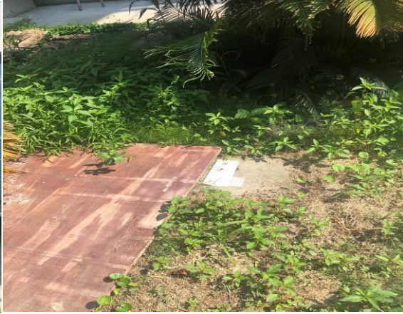
污水处理设施
