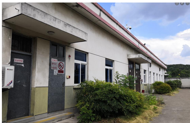
110kV 莲花变电站主控楼
