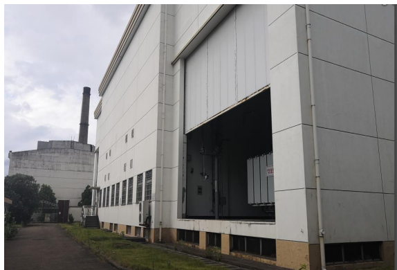
110kV 兰溪变电站现有主变
