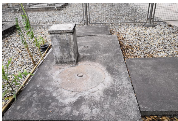
110kV 龚塘变电站污水处理设施
