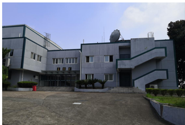
220kV 云山变电站主控楼
