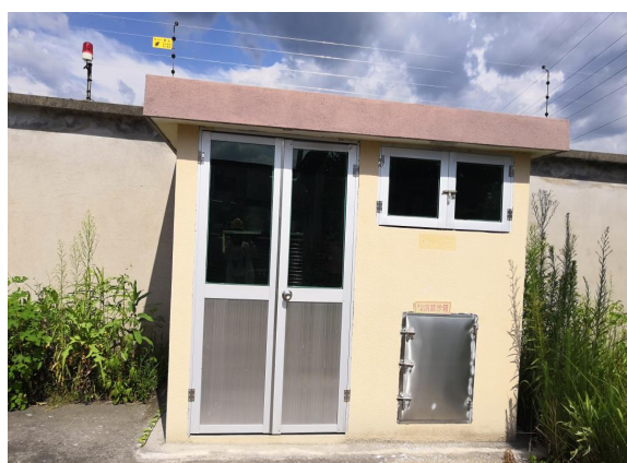
110kV 莲花变电站主变消防室
