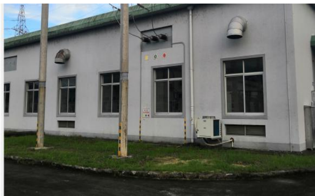
110kV 中洲变电站主控楼
