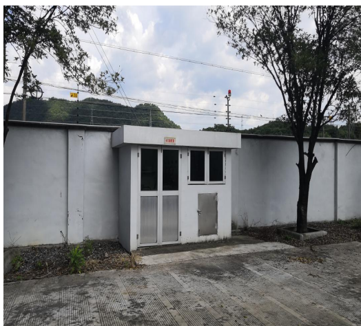
110kV 六洞山变电站主变消防室
