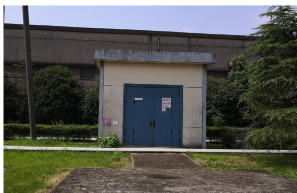
220kV 云山变电站主变消防室
