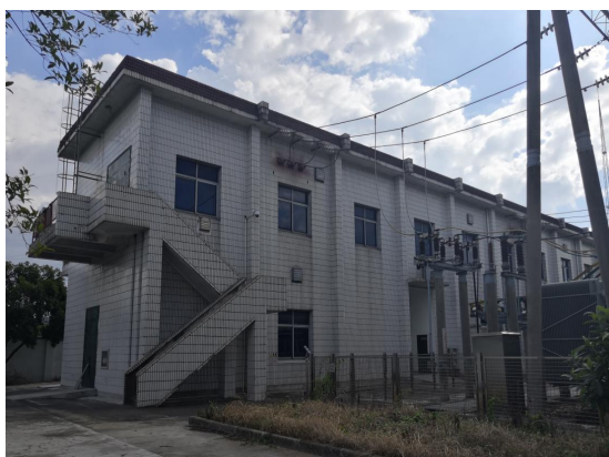
110kV 六洞山变电站主控楼
