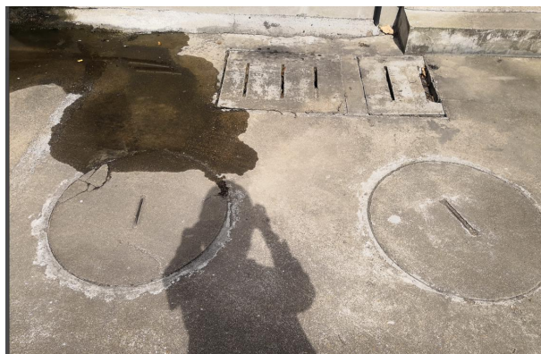
110kV 莲花变电站污水处理设施
