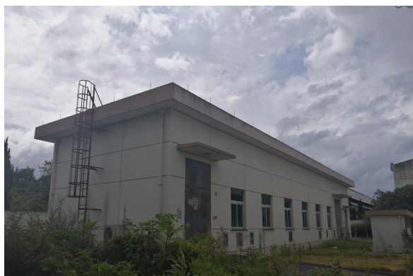
110kV 兰溪变电站主控楼
