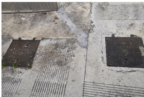
110kV 六洞山变电站污水处理设施
