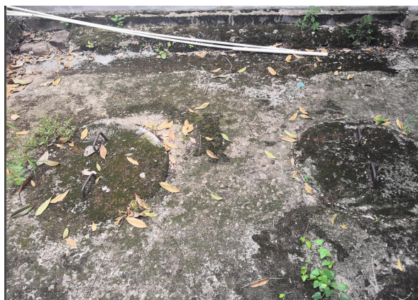
110kV 中洲变电站污水处理设施
