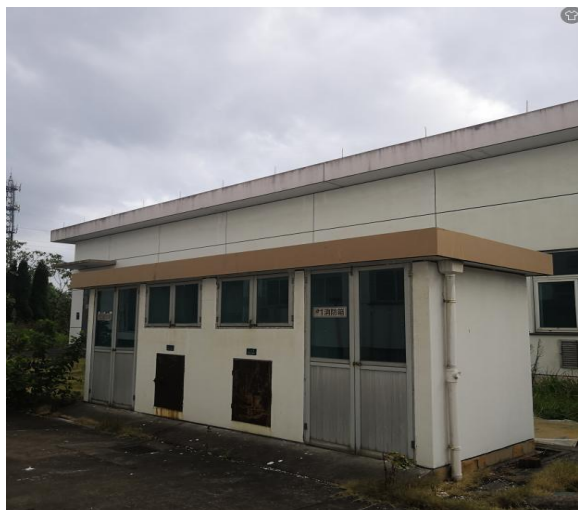
110kV 兰溪变电站主变消防室
