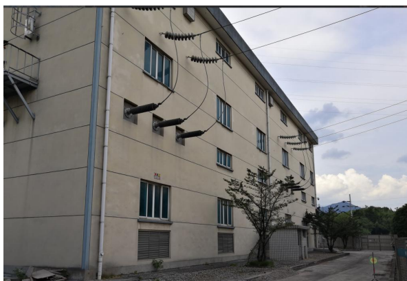
110kV 龚塘变电站主控楼
